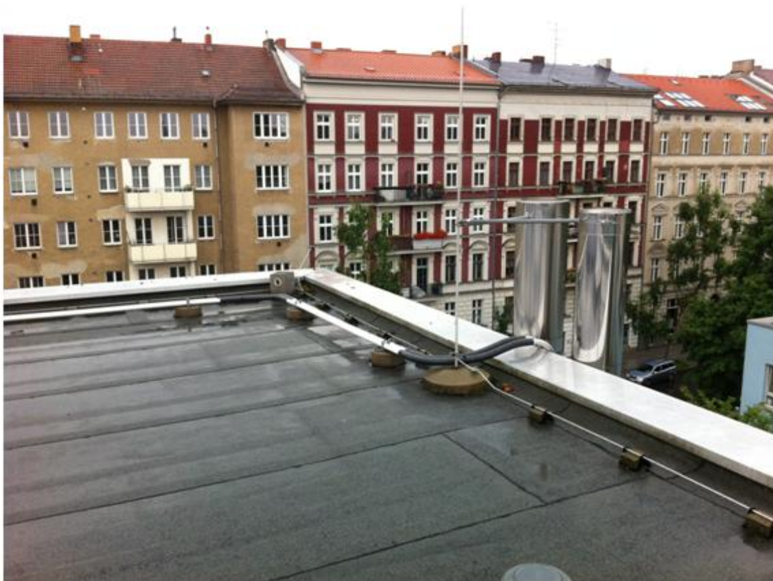
Abbildung 32: geplanter Standort PV-Anlage Grundschule am Kollwitzplatz Berlin
