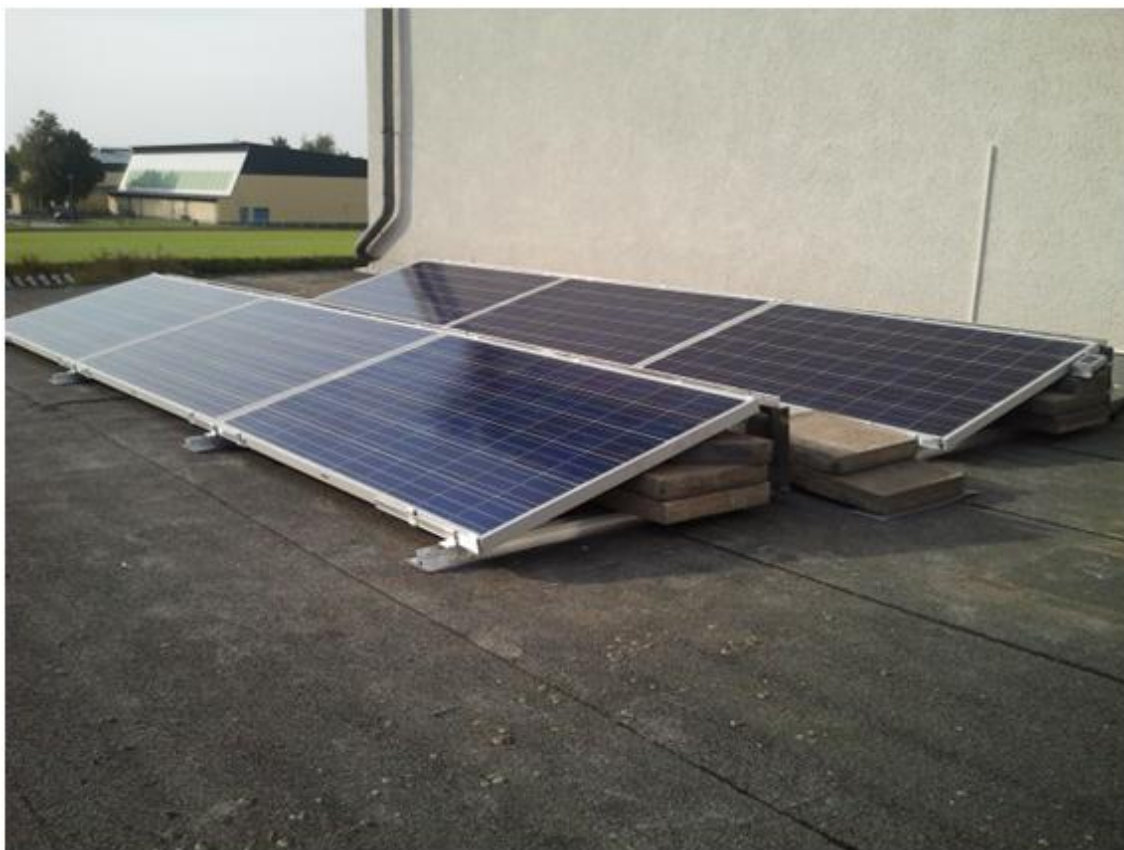
Abbildung 24: PV-Anlage Carl-Diercke-Schule Kyritz
