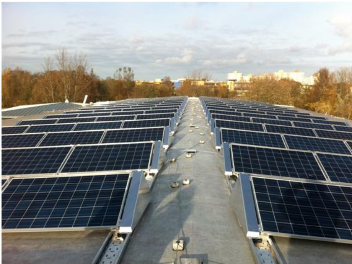
Abbildung 15: PV-Anlage Grundschule am Heidenberger Teich Kiel
