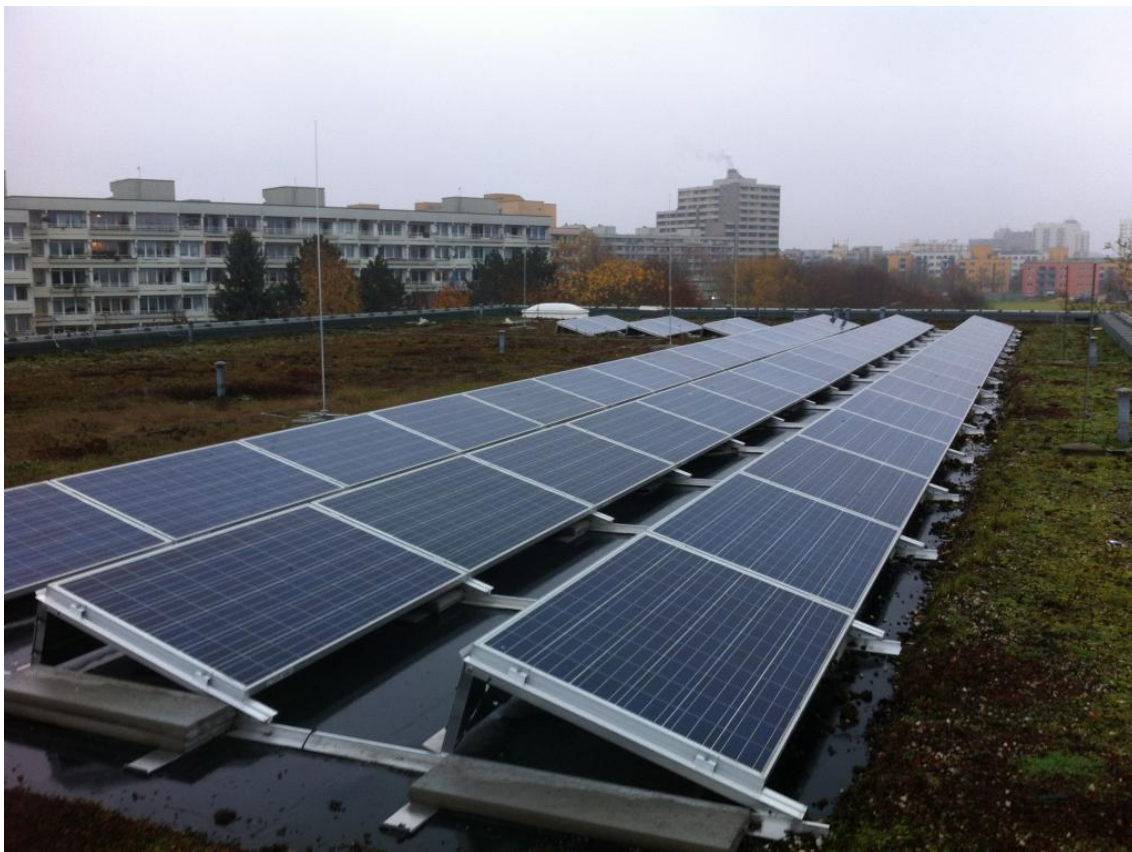
Abbildung 22: PV-Anlage Heinrich-Mann-Schule Berlin
