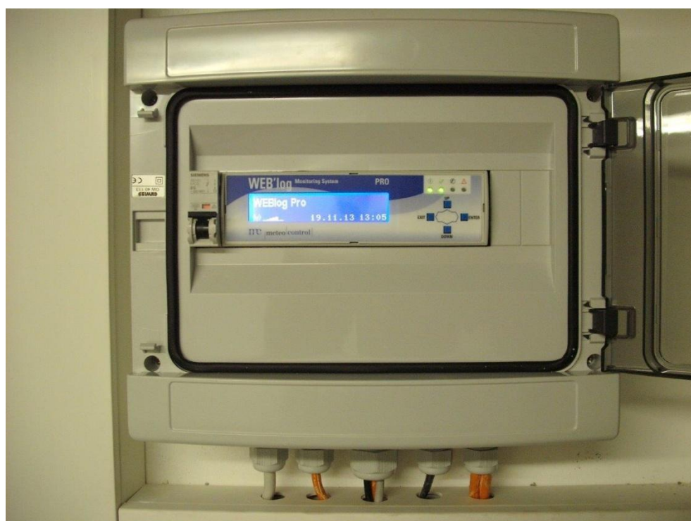
Abbildung 7: Datenlogger Weblog Pro Unlimited im Einbaugeschütz
