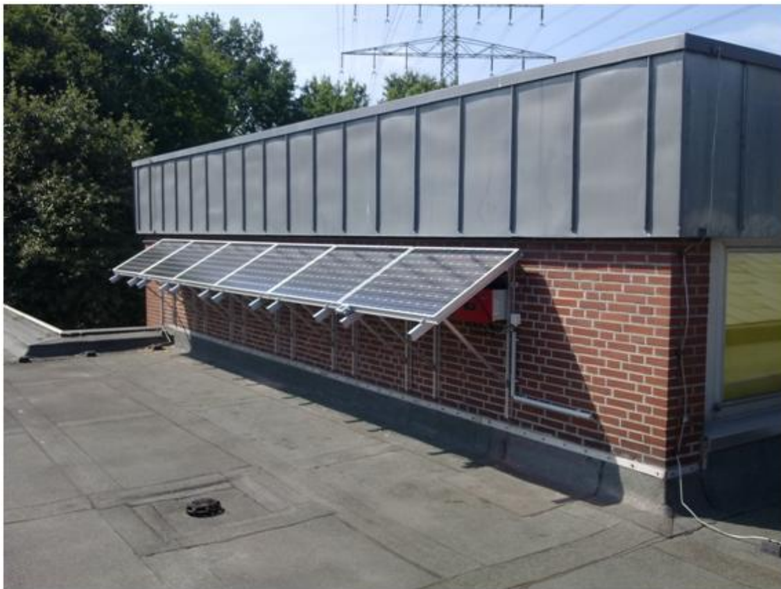
Abbildung 19: PV-Anlage Schule Bekkamp Hamburg
