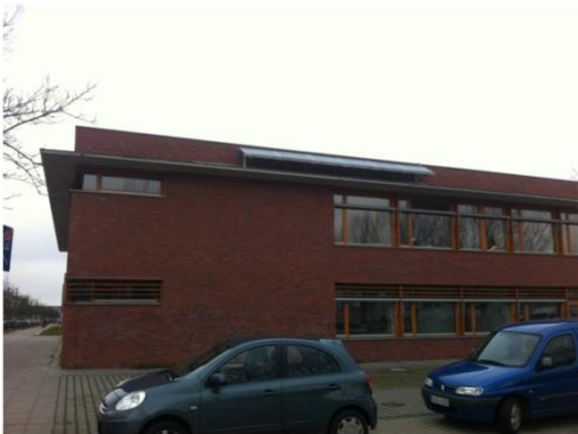
Abbildung 16: PV-Anlage Grundschule am Hohen Feld Berlin
