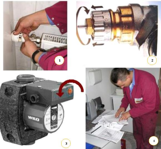
Maßnahmen zur Optimierung einer Heizungsanlage
