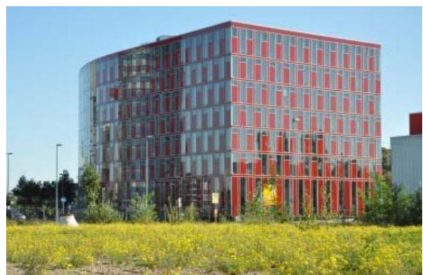
Multifunktionales Fassadenmodul des Capricornhaus in Düsseldorf
