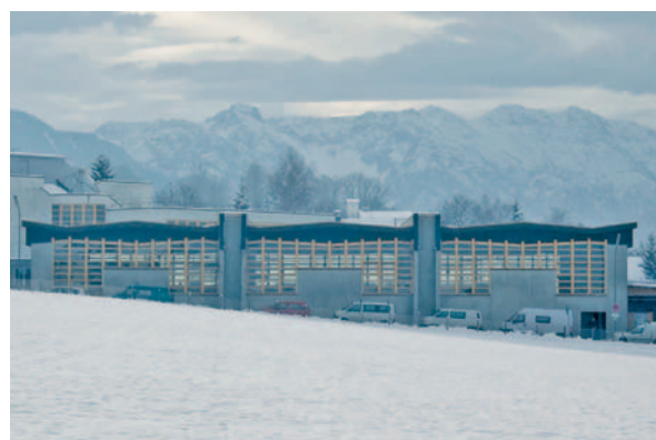
Abb. 1: Turnhalle in Murnau, Landkreis Garmisch-Partenkirchen
