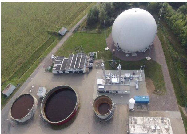
Biogasaufbereitungsanlage mit Gasspeicher
