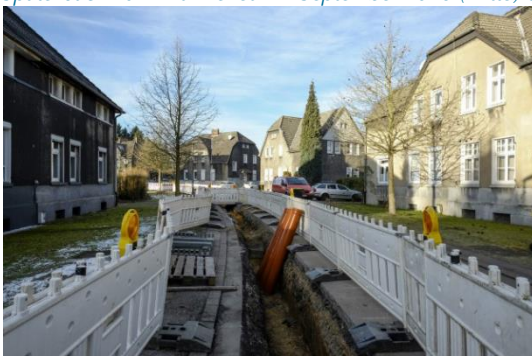
Spatenstich zum Wärmenetz im September 2016 (mitte) und Straßenarbeiten zur Verlegung des Wärmenetzes (links, rechts)
