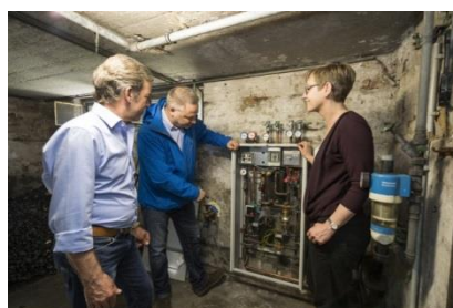
Neue Übergabestation Nahwärme
