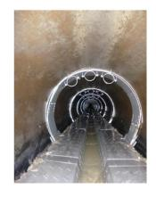
wird mit sieben Megawatt Leistung in der Spitze und mit neun Gigawattstunden Energiebedarf pro Jahr abgeschätzt. Die Wärme zur Warmwasserbereitung soll in der Heizzentrale mittels eines Blockheizkraftwerks erzeugt werden. Die vier Leiter des Netzes speisen die Niedertemperatur-Raumwärme sowie das Heißwasser zur Warmwasserbereitung (jeweils Vor- und Rücklauf).
