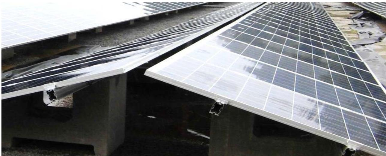
Die Solarmodule wurden in Ost-West Richtung und nicht wie gängig in Südrichtung installiert. Die Vorteile: Der Flächenverbrauch war um 40 Prozent geringer als bei der Südausrichtung der Anlage, der Eigenstromanteil höher und die Investitionen sowie die spezifischen Installationskosten um rund 7,5 Prozent niedriger. Die Photovoltaik-Anlage besteht aus 1.000 Einzelmodulen und acht Wechselrichtern und hat eine Leistung von 254 Kilowatt<sub>p</sub>.
