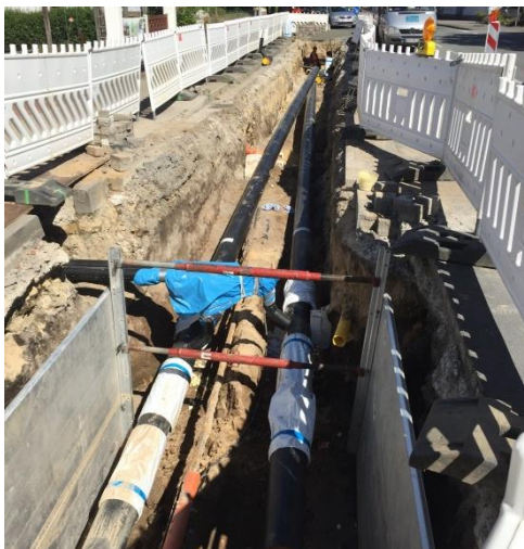
Verlegung der Rohrleitungstrasse
